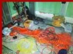
اجرای اتاق سرور
